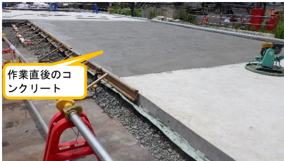
(写真 2 - 3) 作業直後のコンクリートの状況
