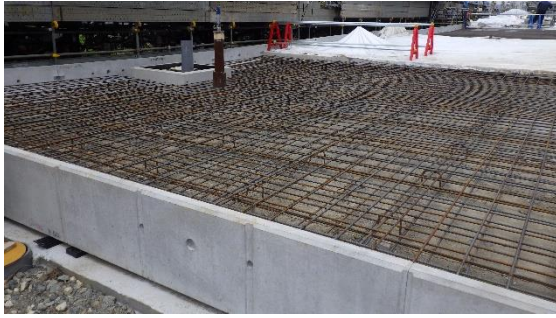
(写真 2 - 2) コンクリート打設前の型枠の状況
