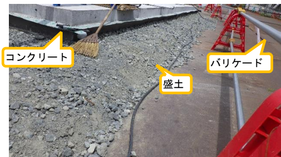
(写真2-1) フェーシング作業の状況
