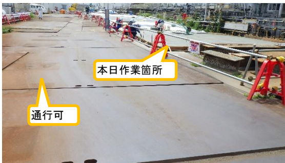
(写真1) フェーシング作業エリアの状況 (北側から撮影)
