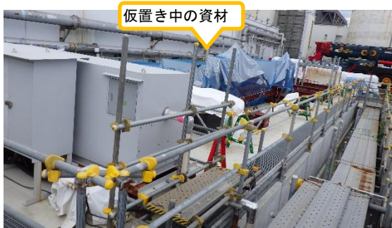
(写真2-1) フェーシングの状況①
