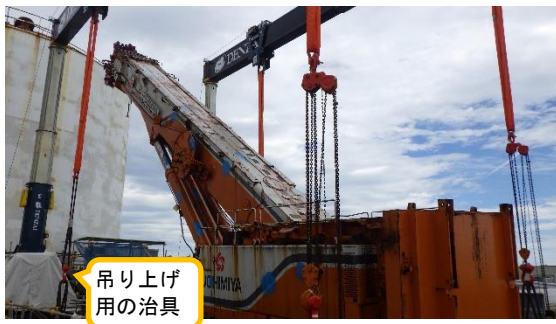
(写真 3) クレーン車撤去工事の状況
