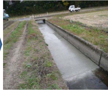
補修した水路
