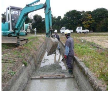
自主施工による補修作業
