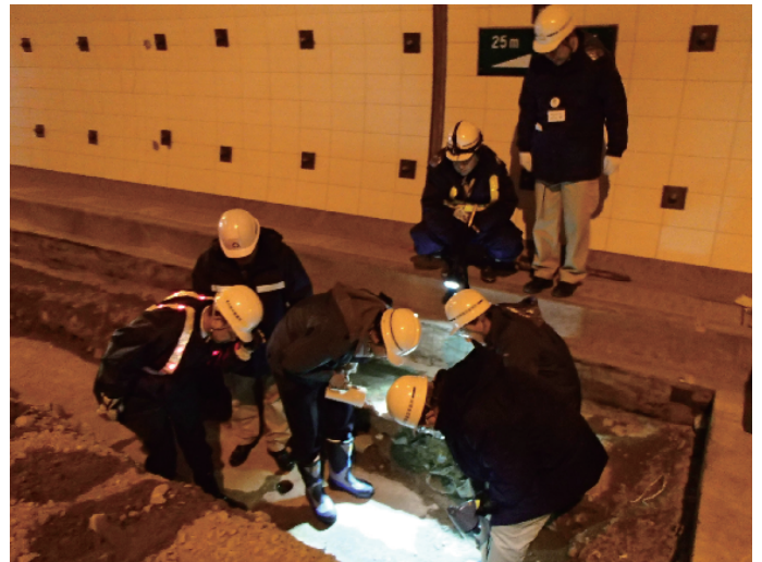
現地調査の状況
