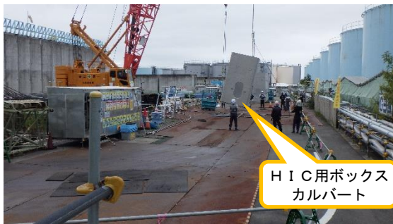
(写真2-1) H I C用ボックスカルバートの荷受け作業の状況 (西側から撮影)
