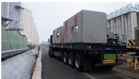
(写真3) H I C用ボックスカルバートの運び込みの状況 (南側から撮影)
