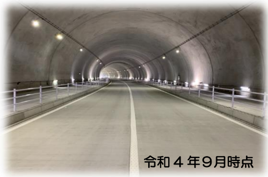
南湖トンネル 延長 L=474.0m 幅員 W=6.5(14.5)m
