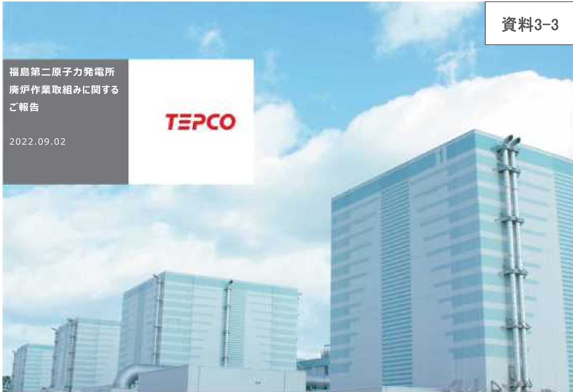
福島第二原子力発電所
