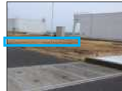
解体後 水色の枠線内が建屋を解体した跡地
