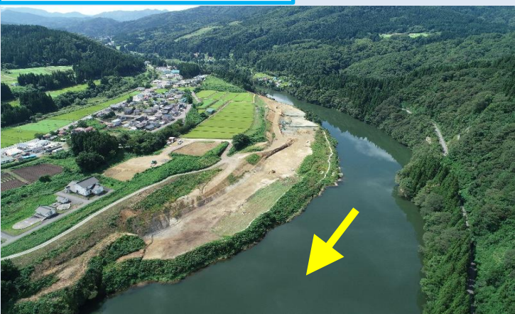
施工中（令和4年9月時点）
