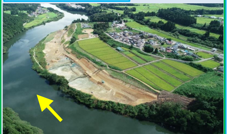
施工中（令和4年9月時点）
