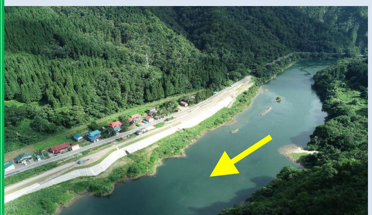
施工中（令和4年9月時点）
