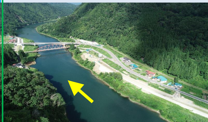
施工中（令和4年9月時点）
