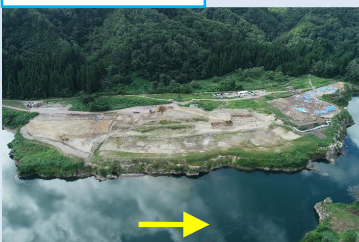
施工中 (令和4年9月時点)
