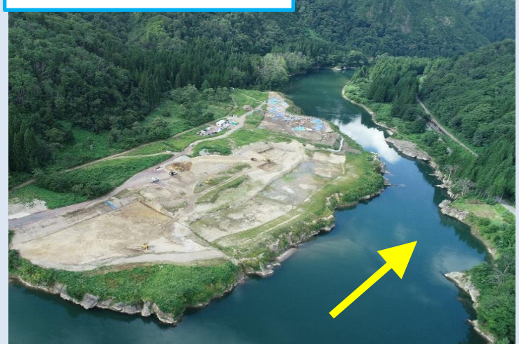
施工中 (令和4年9月時点)
