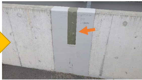
(写真4-2) 外堰被覆損傷修復の例（写真3-1 と同じ場所、今回（11月4日）撮影）
