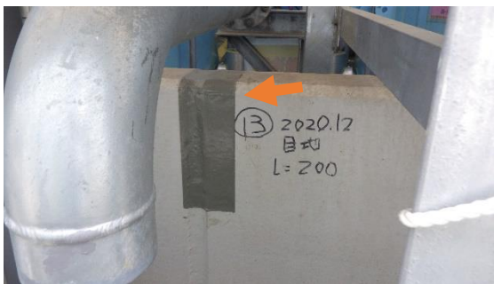
(写真4-3) 内堰被覆損傷修復の例（今回（11月 4日）撮影）
