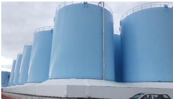
(写真1) Bタンクエリア概観 (北側から撮影)
