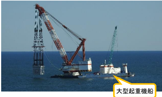
(写真1-1) 据え付け作業の状況①
