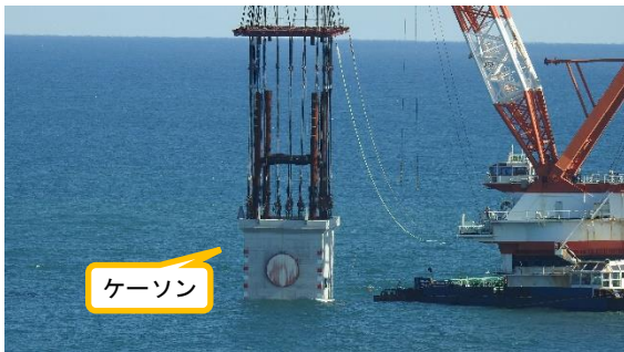
(写真1-2) 据え付け作業の状況②
