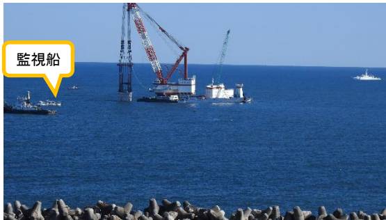
(写真2) 作業中の海上の状況
