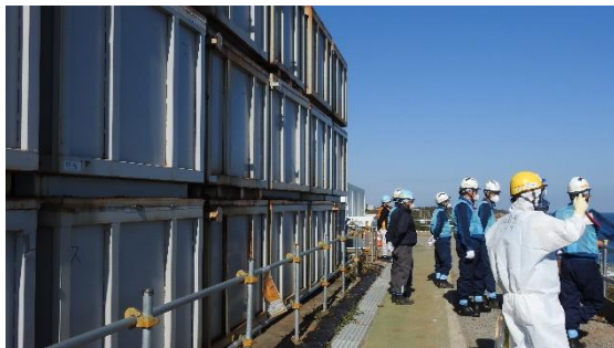
(写真3) 作業確認の状況
