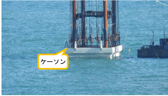
(写真1-3) 据え付け作業の状況③
