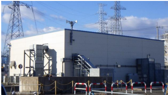
(写真3-1) 所内共通M/C建屋の状況
