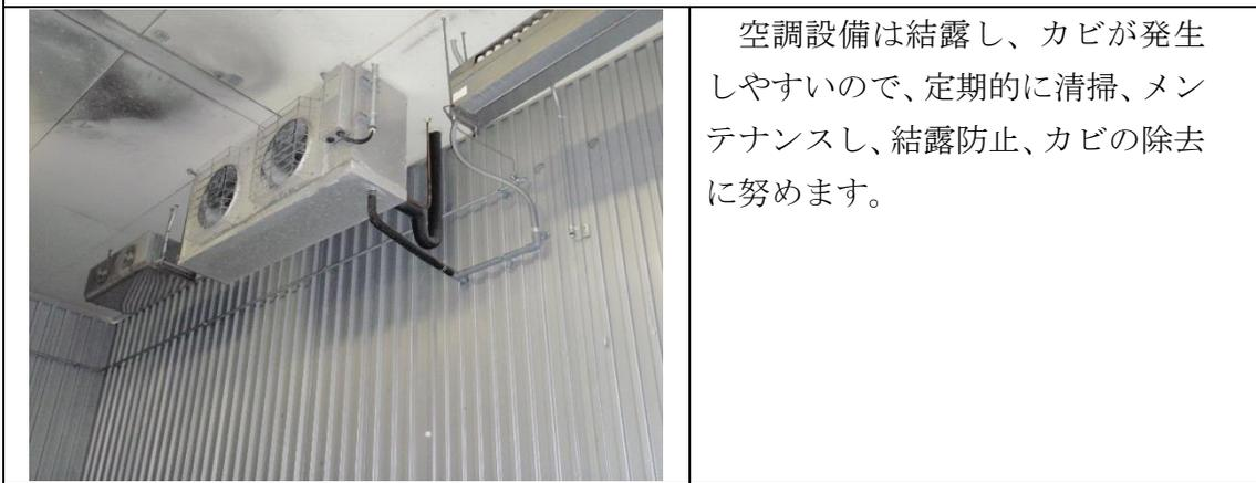
図2 空調設備の清掃・メンテナンス
