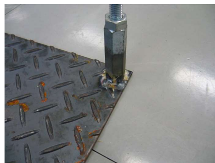
鉄板とナットのスポット溶接
