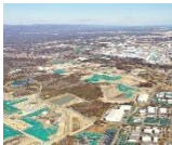
中間貯蔵施設
