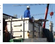
PCB廃棄物の撤去
