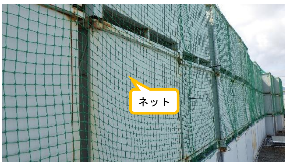
(写真1-2) 一時保管エリアJのコンテナ保管状 況の例
