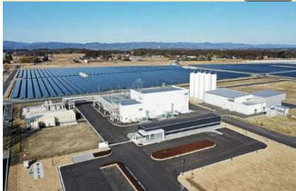
18万平方mの敷地内に設置された2万kWの太陽光発電による電力を用いて世界最大級となる1万kWの水電解装置で年間約200トンの水素を製造します。
