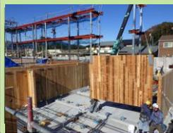
CLT壁パネルの建込状況
