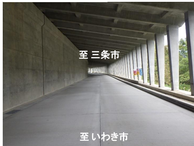
スノーシート工事状況
