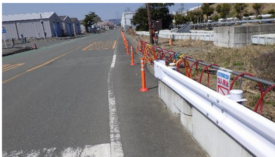
(写真1-1) A排水路(暗渠)の状況 (免震重要棟北側道路を東側から撮影)
