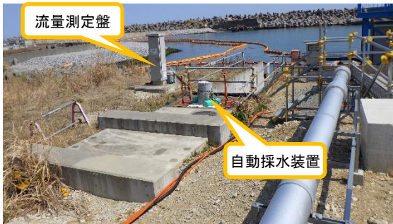
(写真 4 - 1) A排水路流末付近の状況① (南西側から撮影)
