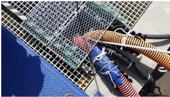
(写真 3 - 4) 排水汲み上用ポンプの設置状況
