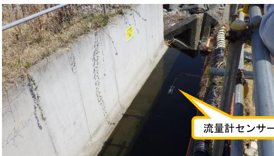
(写真 4 - 2) A排水路流末付近の状況② (南西側から撮影)
