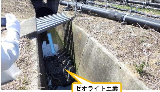
(写真 2 - 1) 集水枡上流側の開渠の状況 (北東側から撮影)
