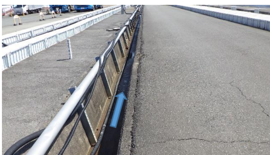
(写真1-3) A排水路(開渠部分)の状況② (免震重要棟南側道路を西側から撮影)
