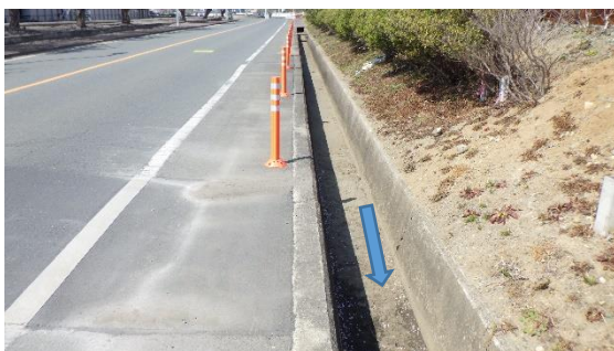
(写真1-2) A排水路(開渠部分)の状況① (免震重要棟北側道路を東側から撮影)
