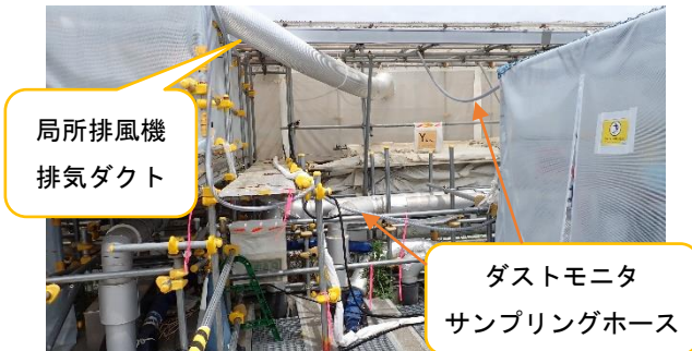
(写真1-2) 濃縮水タンク周辺の状況(2)
