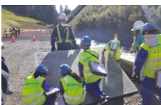
建設現場見学会
