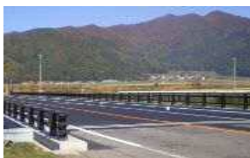
橋梁の長寿命化対策(施工後)
