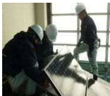
太陽光発電設備施工訓練 (テクノアカデミー会津)
