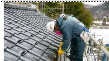
住宅除染（雨どい堆積物除去）
