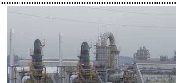
仮設焼却炉の設置
