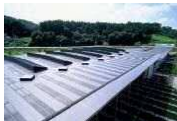
太陽光発電(福島県農業総合センター)
