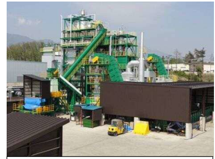
木質チップを活用したバイオマス発電
