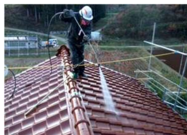
住宅の除染作業
