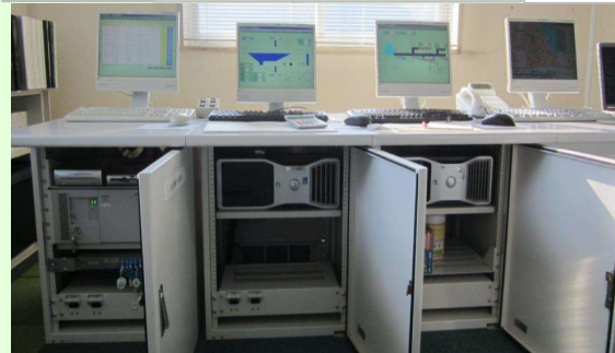
ダム管理用制御処理装置改良工事
