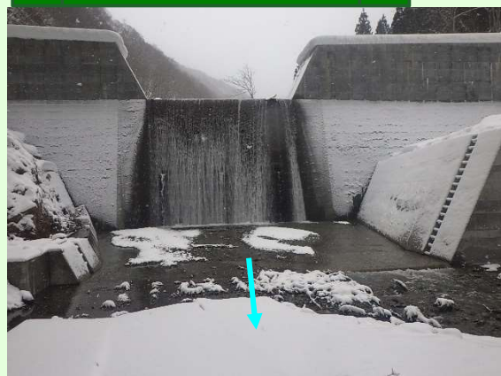
施工状況（博士堰堤）
