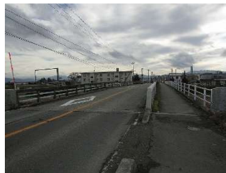
②補修箇所の確認
