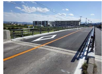
③補修施工を行い完了
