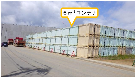
(写真 3 - 2) 南北エリア南側 6 m 3 コンテナの保管状況 (南東側から撮影)
