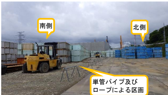
(写真 4 - 1) 東西エリア 単管パイプ及びロープによる区画状況 (東側から撮影)
