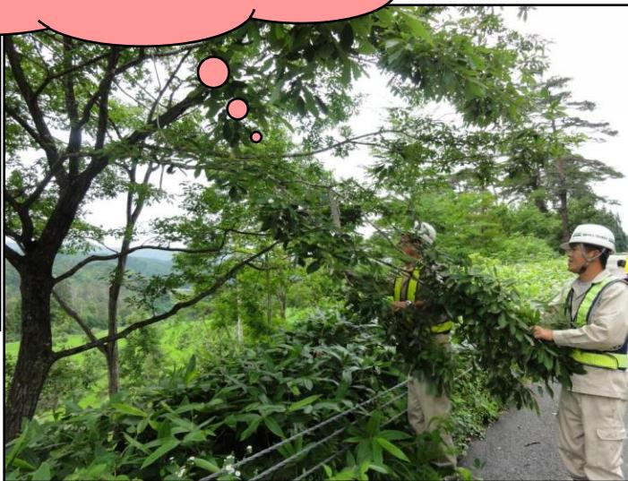
パトロールは、平常時パトロール、異常時パトロール、地震時パトロール及び主要構造物パトロールに分かれており、平常時パトロールは、それぞれの道路の交通量に応じてパトロールの頻度を定めています。
