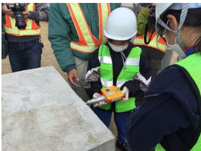
コンクリート強度測定
