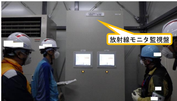
(写真 2 - 2) 放射線モニタ (A) の「校正検査」 の状況② (放射線モニタ指示値の確 認状況)
