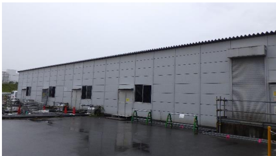
(写真1-1) 多核種移送設備建屋の外観 (南西側から撮影)
