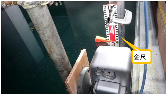
(写真1-2) 金尺の設置状況
