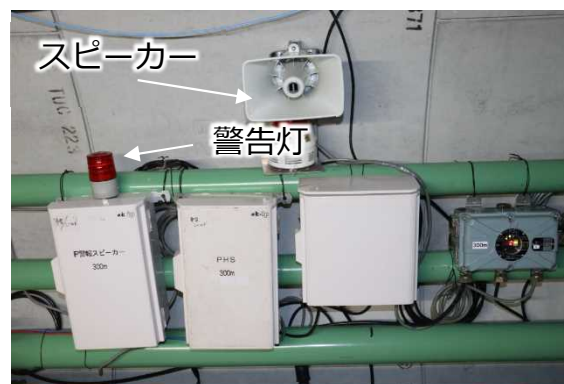
緊急時の合図設備
