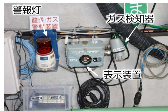
メタンガス、酸欠対策のガス濃度検知器と測定値表示板
