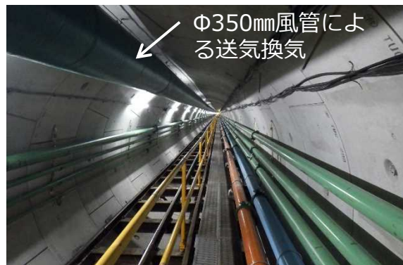
酸素欠乏症対策の坑内換気
