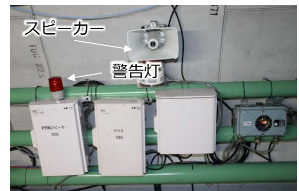
緊急時の合図設備
