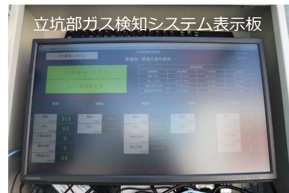
メタンガス、酸欠対策のガス濃度検知器と測定値表示板
