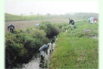
▶ 棚倉堀の清掃 作業
