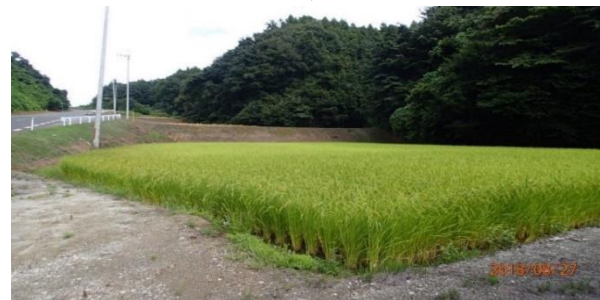
中間貯蔵施設に搬出後、原状回復工事で田んぼに復旧
