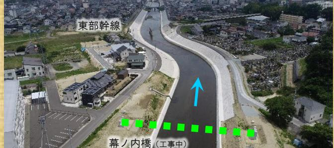
④ 東部幹線から幕ノ内橋上流部間の築堤護岸が概ね完了しました。令和5年度から幕ノ内橋上部工に着手しています。
