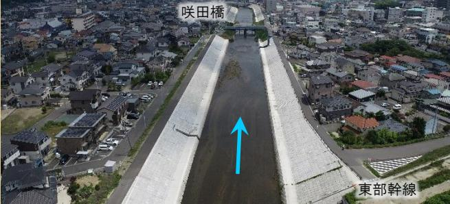
③ 咲田橋から東部幹線間の築堤護岸及び堤防道路が完了しました。令和5年度から咲田橋架け替えのため、旧橋撤去工事に着手しています。
