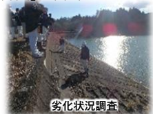
劣化状況調査
