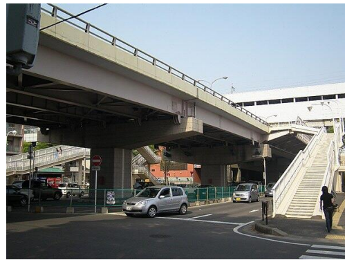
西側歩道への階段とあづま陸橋
