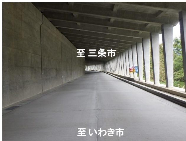
スノーシート工事状況
