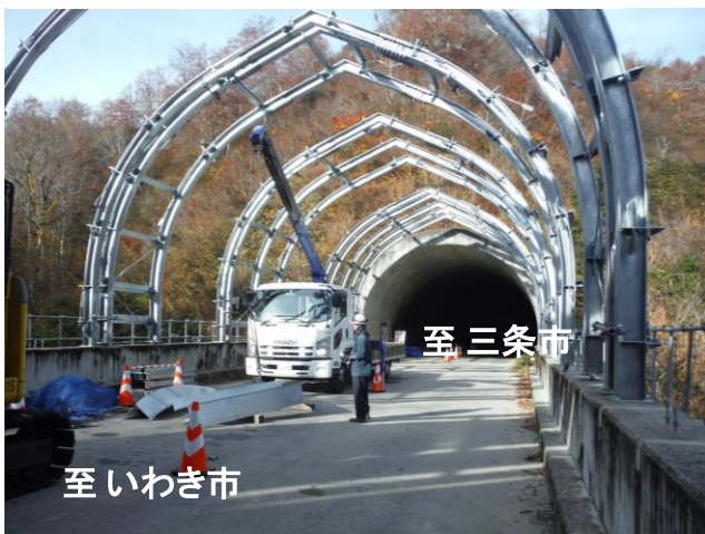
ナコ沢スノーシェルター工事状況
