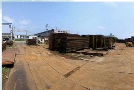
写真：敷鉄板全景
