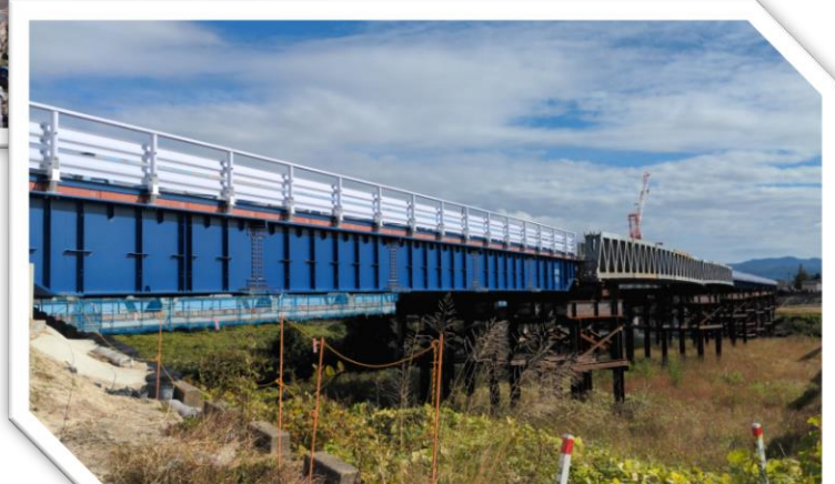
横から見た仮橋
