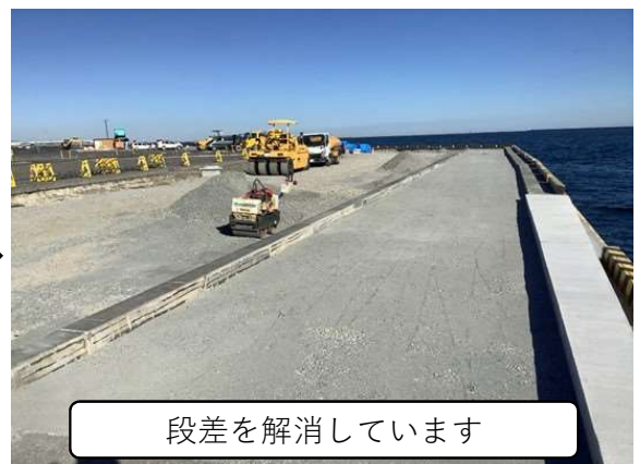
3号ふ頭護岸 復旧中
