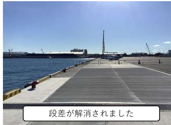
第2船だまり物揚場 復旧後
