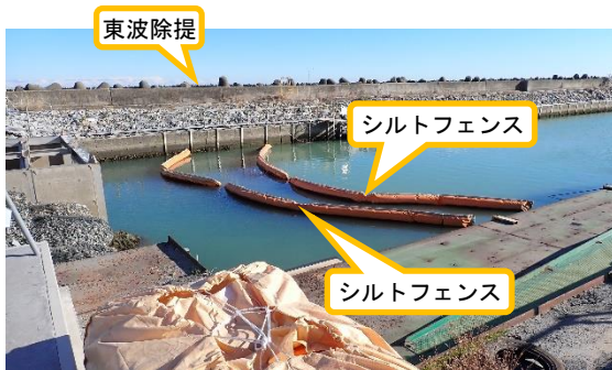
(写真3) 1-4号機取水路開渠出口付近のシルトフェンス設置状況 （北西側から撮影）
