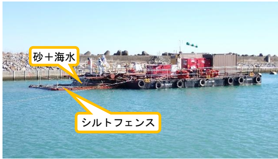
(写真2-1) ユニフロート台船による覆砂投入作業の状況①（北西側から撮影）
