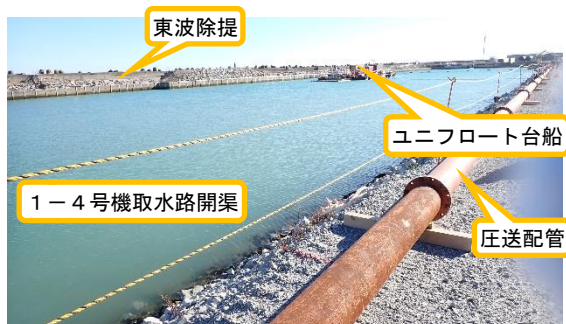
(写真1-2) 圧送配管の敷設状況 (北西側から撮影)
