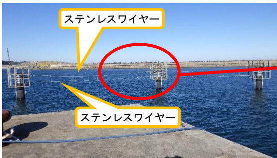
(写真5-1) ステンレスワイヤーの設置状況① (南西側から撮影)
