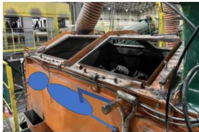
事故発生時の状況
