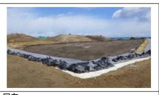
**同左** 周囲に土堰堤が築堤されており、除去土壌の 流出防止が図られていた。
