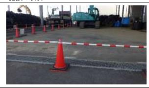
受入・分別施設における除去土壌の受入状況 フレコンバッグの荷下ろし作業では、周囲に側 溝を設けることにより除去土壌等の流出防止対 策が講じられていた。
