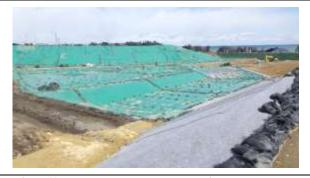
土壌貯蔵施設における除去土壌の埋立状況 雨水等の侵入を防ぎ、除去土壌の飛散を防ぐよ う遮水シートによる表面被覆がなされていた。
