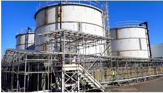
(写真1) 既設ALPSサンプルタンク外観 (南西側から撮影)
