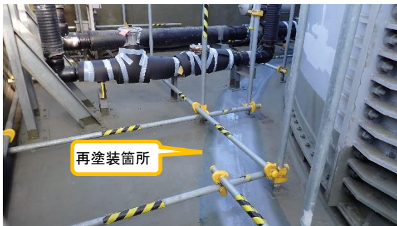
(写真3) 既設ALPSサンプルタンク周辺床 面塗装つなぎ目における再塗装の実 施状況
