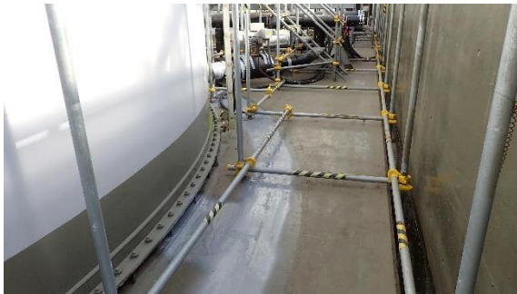
(写真2) 既設ALPSサンプルタンク堰内の 状況
