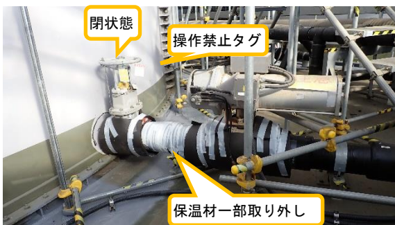
(写真4) 堰内の弁の状況
