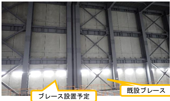
(写真2) 建屋内部の既設ブレースの状況とブレース設置予定箇所（現在ブレースがない場所にブレースを設置する予定）
