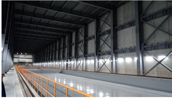
(写真1-3) 貯蔵エリアの状況（北東側から撮影）
