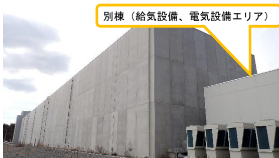
(写真1-2) 大型廃棄物保管庫の外観②（北東側から撮影）
