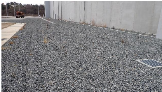
(写真3) 建屋東側バットレス設置予定箇所（砂利が敷かれている場所）
