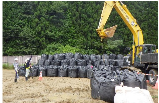
除去土壌等の積込作業
