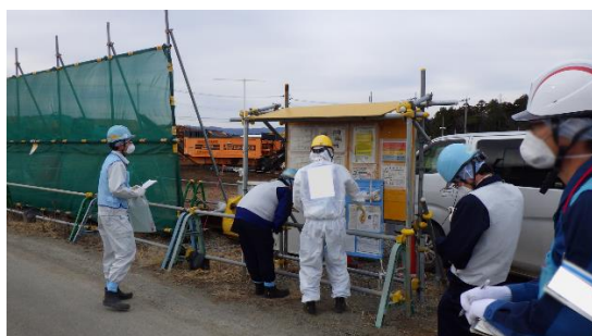
(写真1-1) 安全掲示板で作業の安全確保対策等を確認
