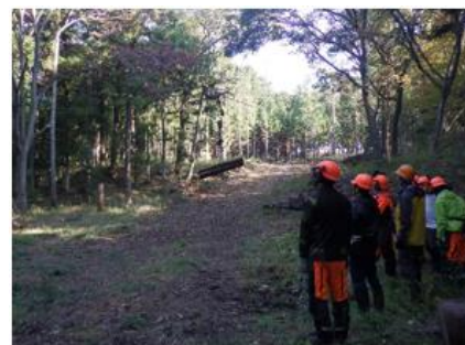
架線集材の様子
