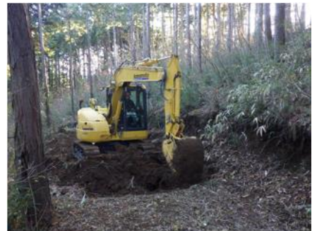
作業道作設実習の様子
