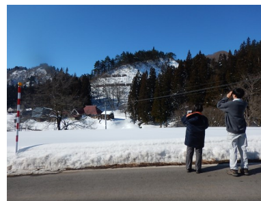
なだれ防止柵と保全対象(人家等)
