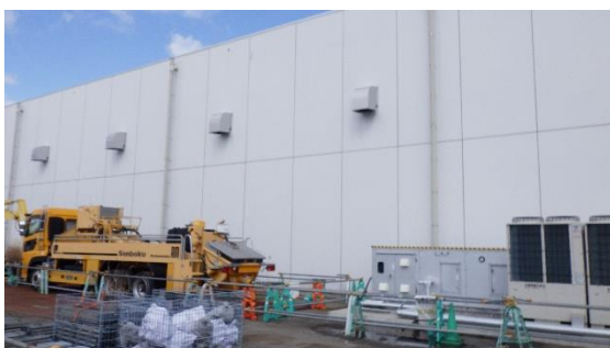
(写真1) サブドレン他浄化設備建屋の外観
