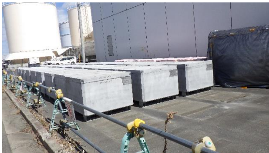
(写真 3) サブドレン他浄化設備建屋西側コン クリート製ボックス仮置き状況
