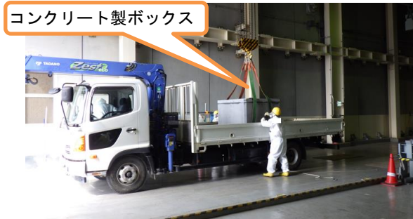
(写真 2 - 3) コンクリート製ボックス運搬の状況
